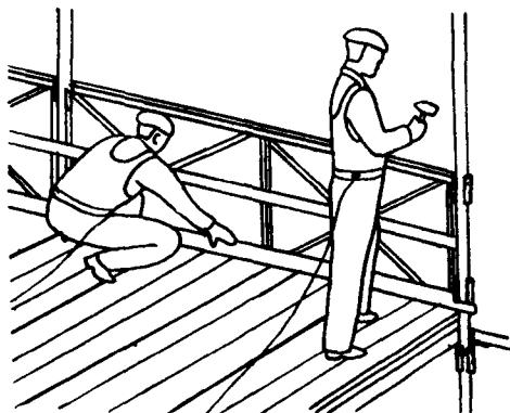
Монтажники  $M_3$  и  $M_4$  подносят элементы ограждения, затем монтажник  $M_3$  поднимается на настил, а монтажник  $M_4$  подает ему перила и бортовые доски. Монтажник  $M_3$  устанавливает перила и закрепляет их шплинтами, а монтажник  $M_4$  устанавливает бортовые доски
