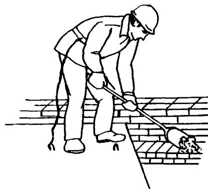
Монтажники  $M_1$  и  $M_2$  очищают кирпичную стену, берут лопатами из ящика раствор и укладывают его на опорную поверхность плиты слоем толщиной 10–15 мм
