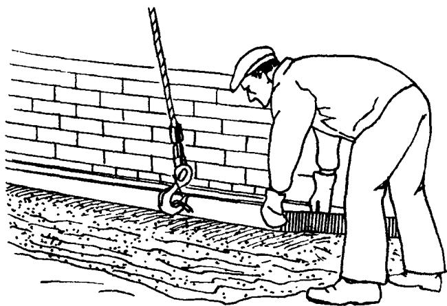
4, 5 РАССТРОПОВКА ПОДДОНА; ВЫВЕРКА И УСТАНОВКА ЕГО В ПРОЕКТНОЕ ПОЛОЖЕНИЕ; 3,5 мин;  $M_1$ ,  $M_2$ ; строп, молоток-кулачок, ломы, лопаты, ящик с раствором, кельма, уровень
