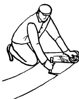
Сразу же после нанесения первого слоя эмульсии кровельщики К<sub>1</sub> и К<sub>2</sub>, держа на весу, раскатывают полотнище стеклосетки до конька крыши, натягивают его и опускают
