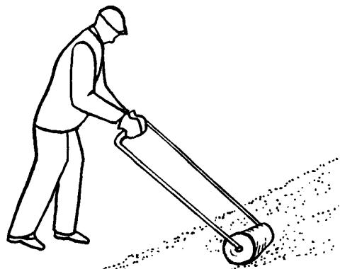
Кровельщики К<sub>1</sub> и К<sub>4</sub> разравнивают гравий деревянными гребками по mastике, а кровельщик К<sub>5</sub> прикатывает выровненный слой гравия катком
