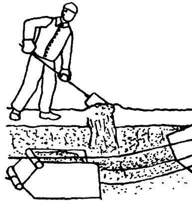
Кровельщик K<sub>1</sub>, пользуясь гребком, а при необходимости лопатой, подает гравий в зону работы скрепера
