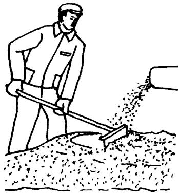
Кровельщик  $K_2$  лопатой или гребком отгребает поступающий из трубопровода гравий.
