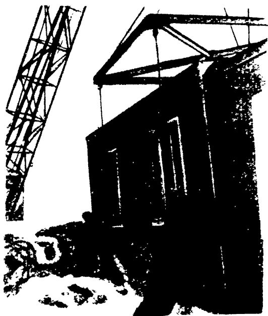
Рис.18. Применение специальной траверсы для монтажа контейнерных зданий
