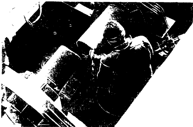
Рис.15. Подготовка торца трубы к сварке
