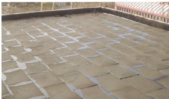
Рисунок 3. Уложенные блоки FOAMGLAS® T4, S3 или F
