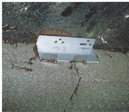
Рисунок 13. Анкер для скрытого крепления PC – Анкер F фирмы FOAMGLAS®
