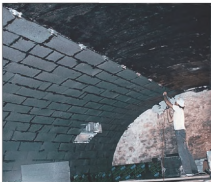
Рисунок 8.1 Общий вид приклеивания блоков пеностекла FOAMGLAS® к потолку
