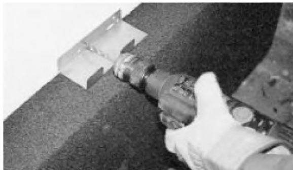
Рисунок 15. Установка Анкера F фирмы FOAMGLAS®
