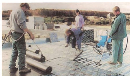
Рисунок 2. Укладка плит FOAMGLAS® READYBOARD на полосы «холодной» мастики
