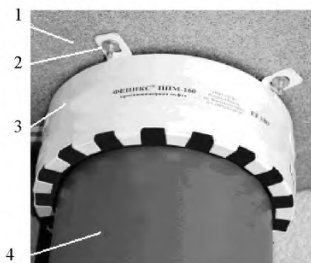
1 – перекрытие; 2 – крепление; 3 – муфта; 4 – труба
