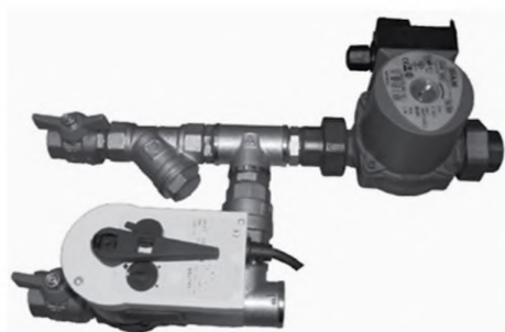
Схема смесительного узла
