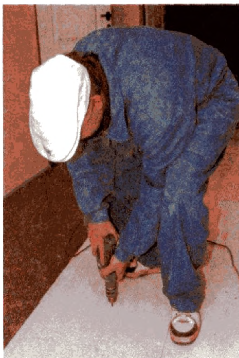
Скрепление элементов пола
