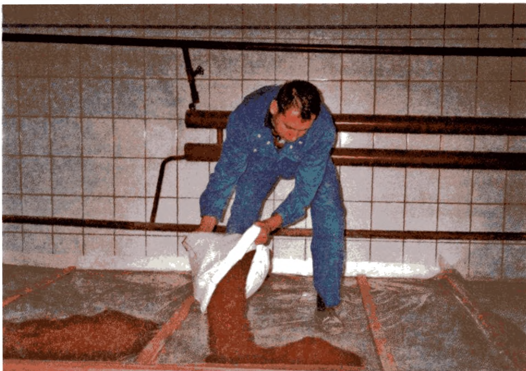
Устройство слоя сухой засыпки по слою пароизоляции
