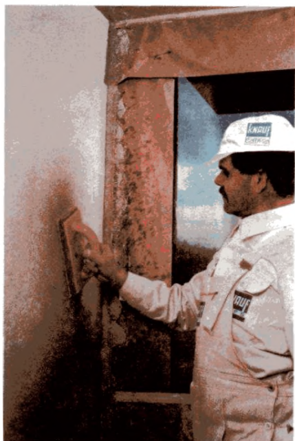
Затирка растворной смеси губчатой теркой
