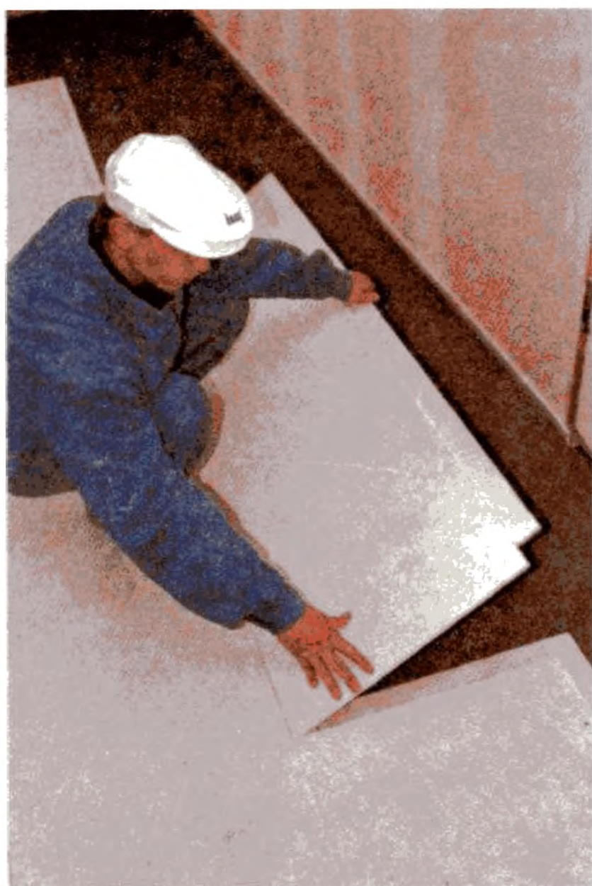
Устройство слоя сухой засыпки по слою пароизоляции
