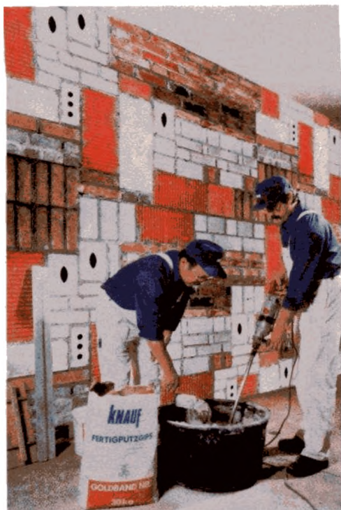
Ручное приготовление гипсовой растворной смеси
