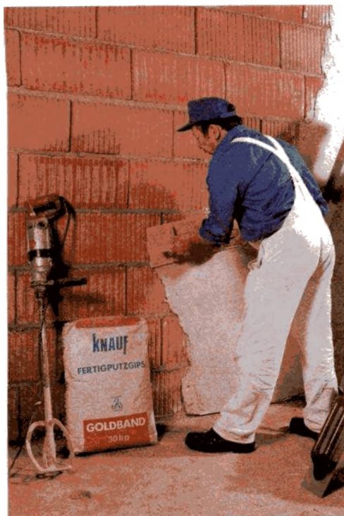
Нанесение гипсовой растворной смеси вручную
