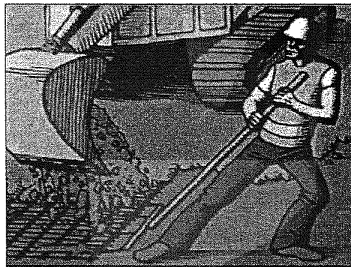
Рисунок 41 – Натяжение георешетки перед засыпкой
