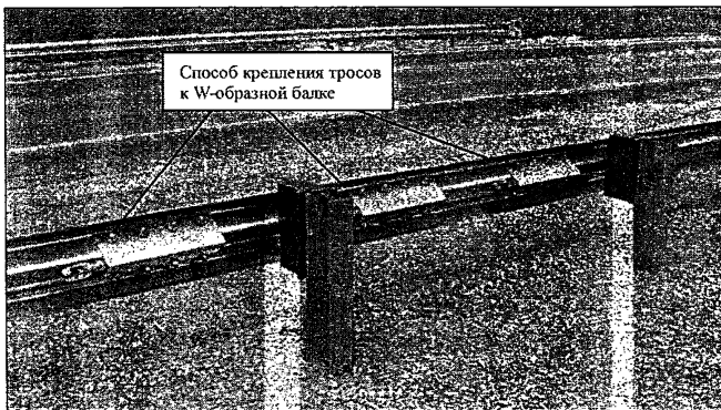
Рисунок 6 – Пример сопряжения профильного ограждения с тросовым
