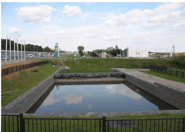
Рисунок 6 – Пруд-отстойник каскадного типа с использованием габионов
