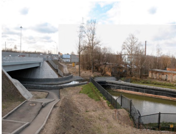
Рисунок 7- Пруд-отстойник с использованием габионов
