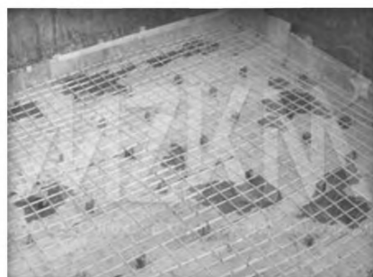
Рисунок 8.3 – Применение АНК для армирования фундаментной плиты 1)
