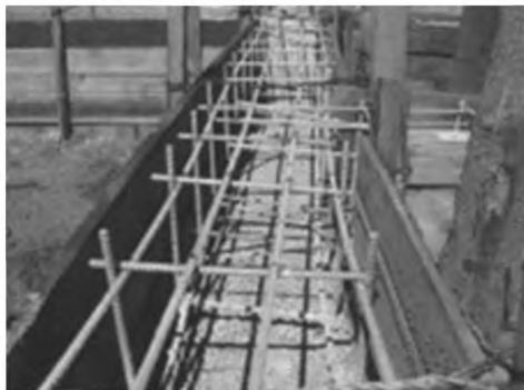
Рисунок 8.6 – Армирование фундамента по периметру сооружения
