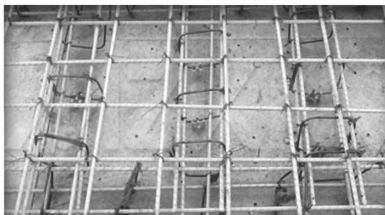
Рисунок 4.3 – Объемный каркас из АНК
