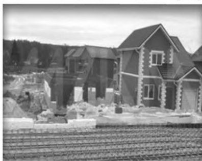
Рисунок 8.3 – Применение АНК для армирования фундаментной плиты 1)
