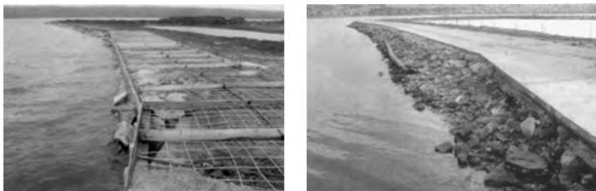
Рисунок 8.23 – Сооружение буны с использованием композитной арматуры 1)
