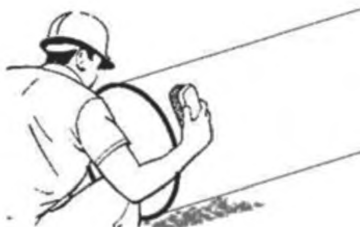
Рисунок Б.1 – Очистка поверхности трубы
