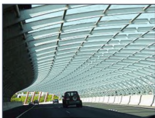
Рисунок 13.2 - Естественное освещение и проветривание шумозащитной галереи
