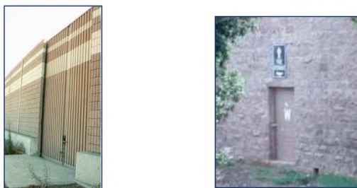
Рисунок 11.34 - Пожарный проход в шумозащитном экране [12]
