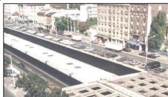
Рисунок 13.2 - Естественное освещение и проветривание шумозащитной галереи
