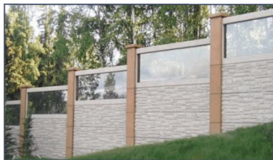
Рисунок 12.10 - Расположение шумозащитного экрана из панелей одинаковой высоты на участке дороги с продольным уклоном
