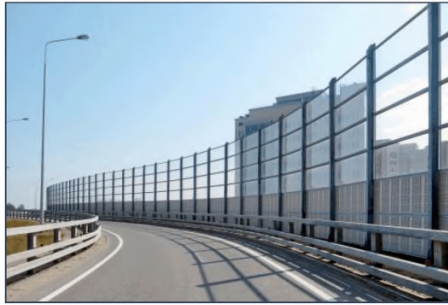
Рисунок 12.20 - Разделение шумозащитных экранов из прозрачных материалов на панели
