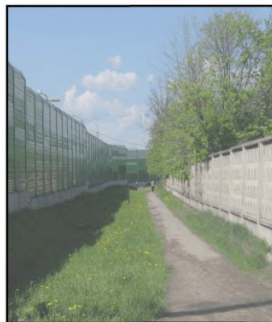
Рисунок 12.3 - Высокий шумозащитный экран создающий «тоннельный эффект» со стороны дороги и «эффект тюрьмы» со стороны застройки
