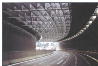
Рисунок 13.2 - Естественное освещение и проветривание шумозащитной галереи
