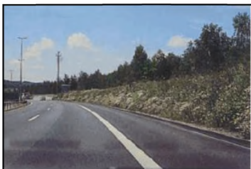
Рисунок 11.49 - Внешний вид шумозащитного вала со стороны проезжей части (а, б, в) и со стороны защищаемой территории (г)
