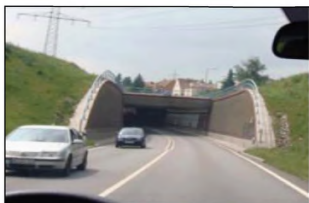
Рисунок 13.3 - Тоннели с полной изоляцией прилегающей территории от транспортного шума (а, б) и с использованием пространства над тоннелем для местного движения (в, г)
