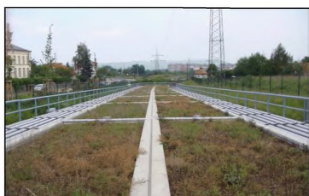
Рисунок 13.2 - Естественное освещение и проветривание шумозащитной галереи
