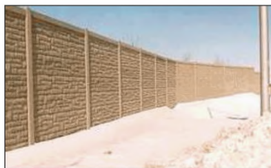
Рисунок 11.38 - Временное размещение снега у шумозащитного экрана в зимний период [12]
