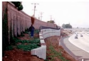
Рисунок 11.58 - Комбинированное шумозащитное сооружения «грунтовой вал – экран– подпорная стенка» со стороны источника шума
