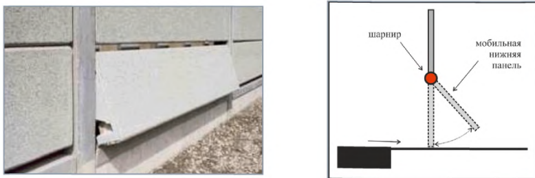
Рисунок 10.43 - Подвешенная нижняя панель экрана для отвода воды с проезжей части
