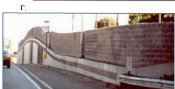
Рисунок 12.9 - Очертания линий верха экрана и защищаемой застройки
