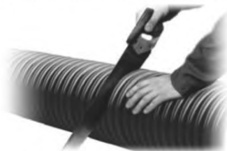
Рисунок 9.20 – Резка ТПСС (стенка из двух слоев – гофрированный наружный и гладкий внутренний слой) плотницкой ножовкой (выкопировка из ТУ 2248-004-50049230-2006 [16])
