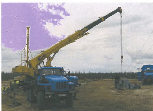
Рис.2.9 - Погрузочно-разгрузочные работы (перемещение нижних балок ростверка); выполнение земляных работ, задание проектной вертикальной отметки, установка опорных столиков и закрепление их к сваям прихваточными сварными швами
