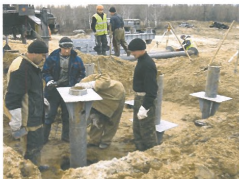
Рис.2.9 - Погрузочно-разгрузочные работы (перемещение нижних балок ростверка); выполнение земляных работ, задание проектной вертикальной отметки, установка опорных столиков и закрепление их к сваям прихваточными сварными швами
