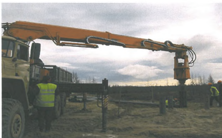
Рис.2.5 - Строповка-захват головы сваи патроном, подъем, перемещение и вертикальное погружение свай в скважину-котлован
