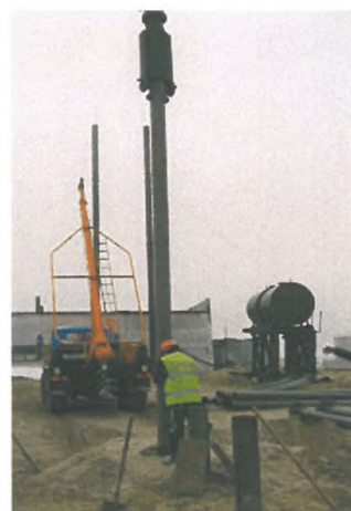
Рис.2.5 - Строповка-захват головы сваи патроном, подъем, перемещение и вертикальное погружение свай в скважину-котлован
