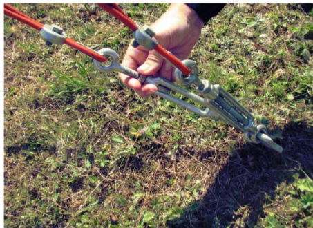
Рисунок 7.3 – Оттяжки на мачте АМК
