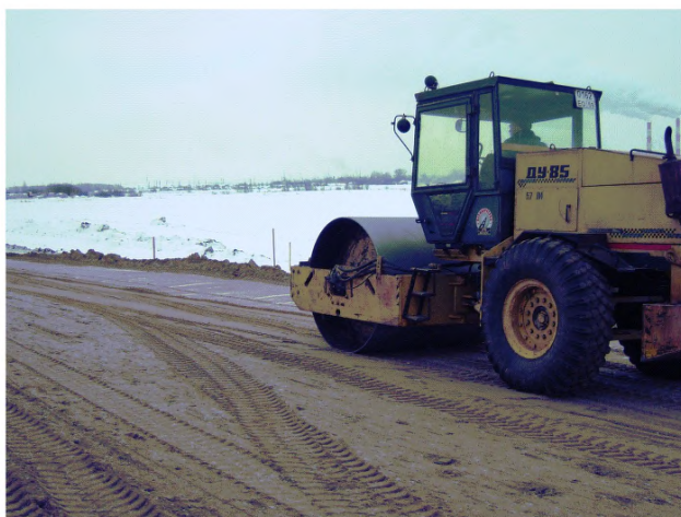
Р и с у н о к Г.5 – Устройство защитного слоя
