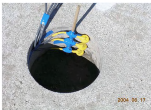
Рисунок 63– Пример установки датчиков температуры в дорожном покрытии [20]
