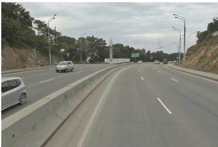
Рисунок 6 – Парапетное дорожное ограждение для разделения транспортных потоков
