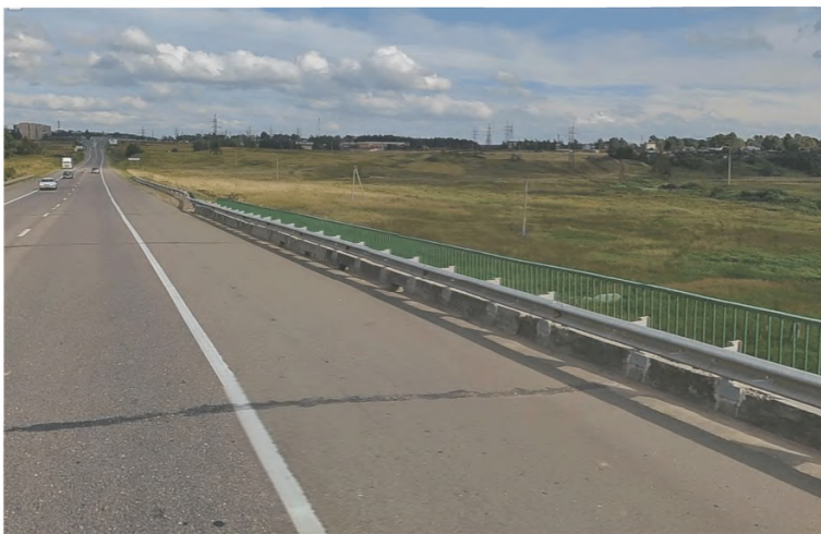
Рисунок 16 - Дорожное ограждение для пешеходов на автомобильной дороге М-9 «Балтия»
