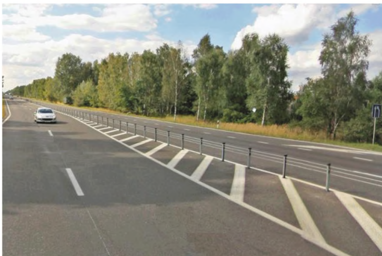
Рисунок 9 – Применение тросового дорожного ограждения на автомобильной дороге для разделения транспортного потока
