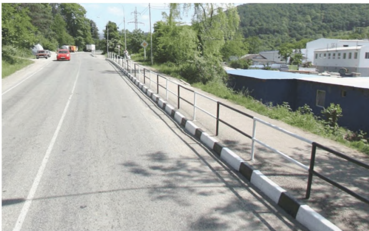
Рисунок 13 – Бордюрное дорожное ограждение вдоль тротуара
