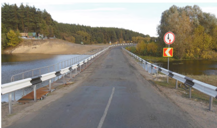
Рисунок 4 – Металлическое барьерное мостовое одностороннее дорожное ограждение
