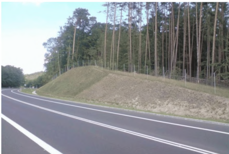
Рисунок 19 – Дорожное ограждение для животных, располагаемое по границе лесного массива
