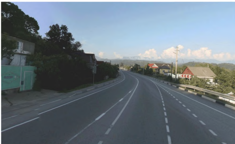
Рисунок 12 – Бордюрное дорожное ограждение на автомобильной дороге А-148 «Адлер - Красная поляна»
