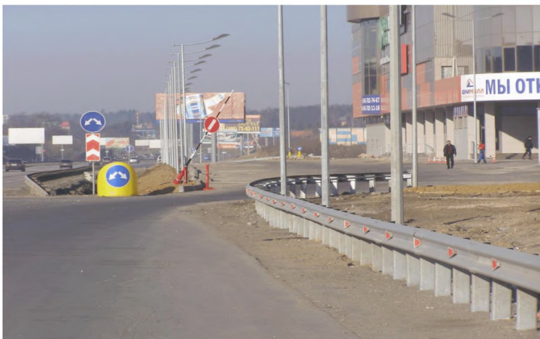
Рисунок 10 – Фронтальное дорожное ограждение в виде буфера на автомобильной дороге М-9 «Балтия»
