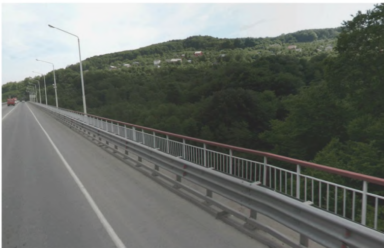
Рисунок 15 – Удерживающее дорожное ограждение для пешеходов (перила) на искусственном сооружении
