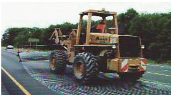
Рисунок 10.1 - Укладки стальной сетки
