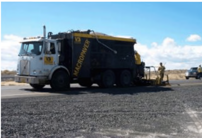
Рисунок 6.3 – Общий вид смесителя-укладчика
