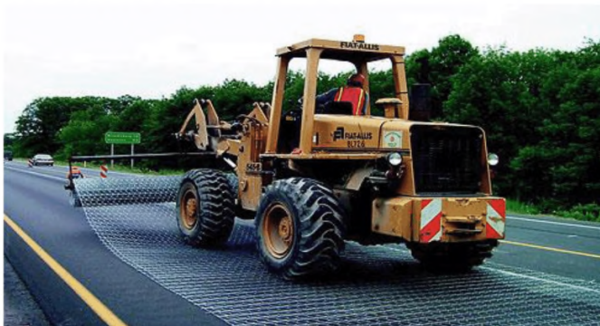
Рисунок 6.6 – Укладка стальной сетки
