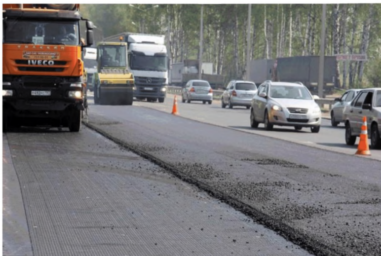
Рисунок 6.5 – Устройство верхнего асфальтобетонного слоя по слою геосетки
