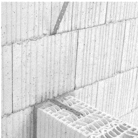
Рисунок В.11 – Пример сопряжения несущих стен с перегородками без перевязки с использованием полосовых анкеров
