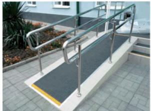
изготавливаются из бетона или представляют собой две полосы металлического швеллера, уложенные параллельно друг другу и оснащенные поручнями. Изготовление и установка пандусов производится строго с учётом требований ГОСТа (действующая версия — ГОСТ Р 51261-99), однако конструкция обязана учитывать в себе индивидуальность места эксплуатации и окружающие условия
