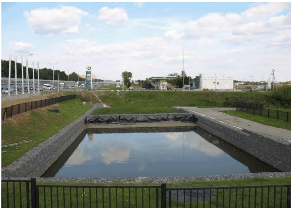
Рисунок 6 - Пруд-отстойник каскадного типа с использованием габионов
