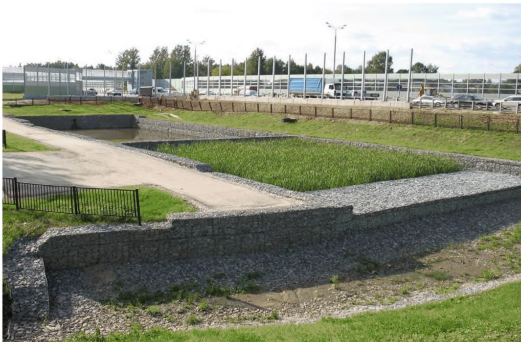
Рисунок 5 - Пруд-отстойник каскадного типа с использованием габионов
