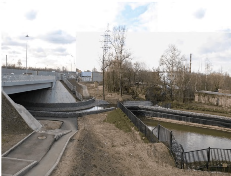
Рисунок 7 – Пруд-отстойник с использованием габионов и сбросом в реку
