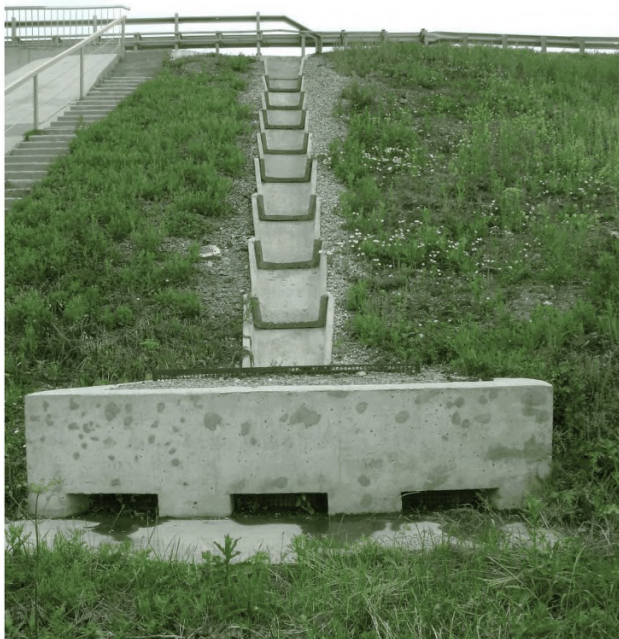
Рисунок 30 – Простейшие очистные сооружения со щебёночной загрузкой
