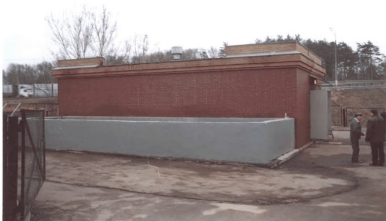
Рисунок 17 - Очистное сооружение индивидуального проектирования (общий вид)
