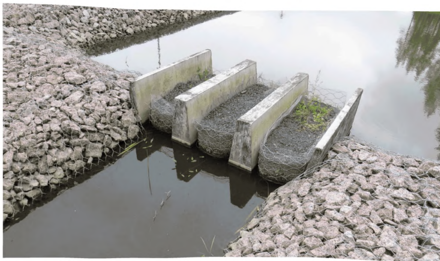
Рисунок 12 – Фильтрующая кассета с загрузкой природным сорбентом
