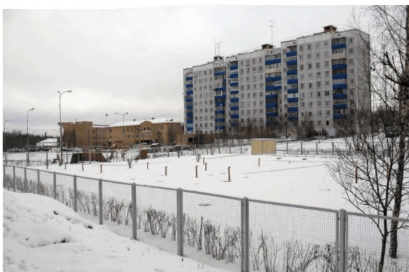
Рисунок 15 - Общий вид очистных сооружений модульного типа
