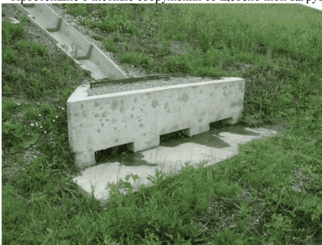
Рисунок 31 – Простейшее очистное сооружение со щебёночной загрузкой (вид сбоку)
