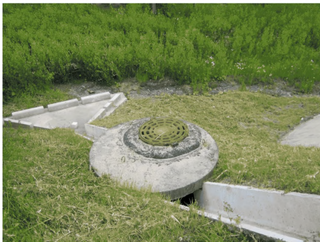
Рисунок 35 – Простейшее очистное сооружение типа «усовершенствованный водоприёмный колодец»
