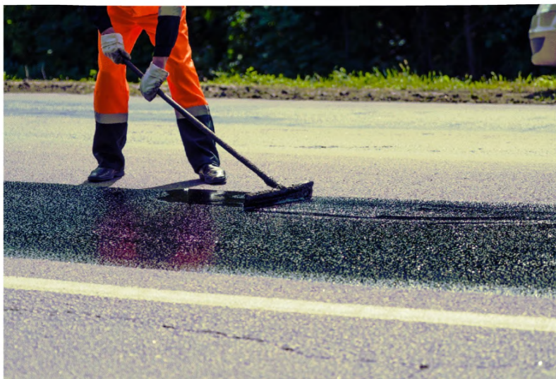
Рисунок 6 – Распределение пропиточного состава вручную
