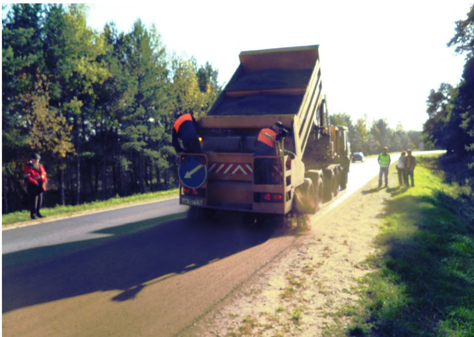
Рисунок 3 – Распределение песка по нанесенной пропитке
