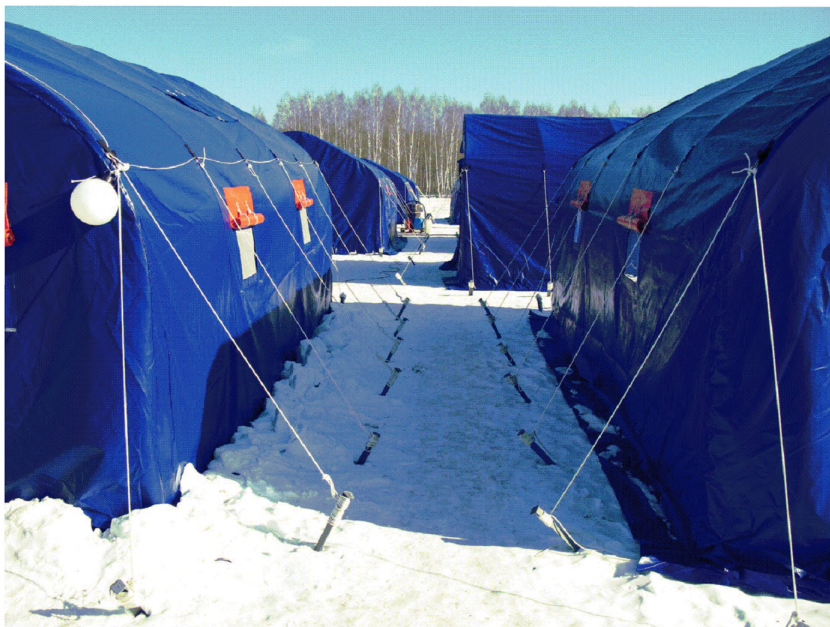
Рис. 2.1.7. Контроль крепления кольев и растяжек для палаток модульных каркасных «Арсенал-5»
