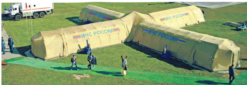
Рис. 2.1.10. Конструкции пневмокаркасных модулей
