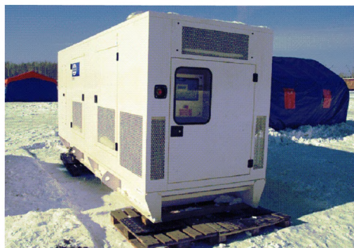
Рис. 2.3.1. Общий вид дизель-генераторной установки FG Wilson P500P3
