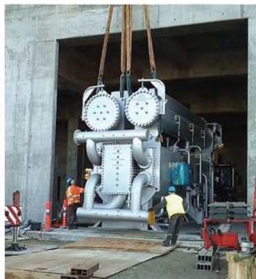
Рисунок 7.5 — Пример применения АБТН на мусоросжигательной ТЭЦ 8)
