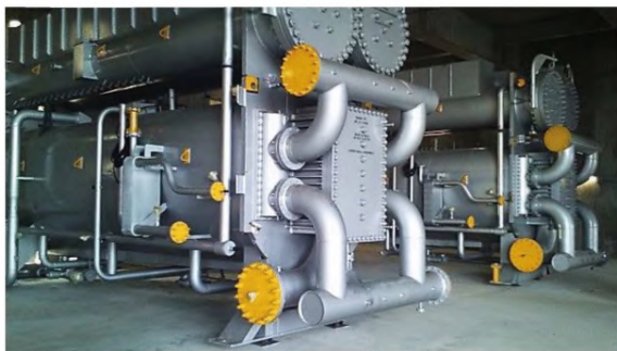
Рисунок 7.5 — Пример применения АБТН на мусоросжигательной ТЭЦ 8)
