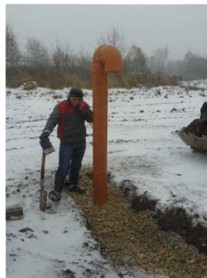
Рис. 2.14 — Газовыпуск при устройстве траншейной системы сбора биогаза (Пермский край) ([46])
