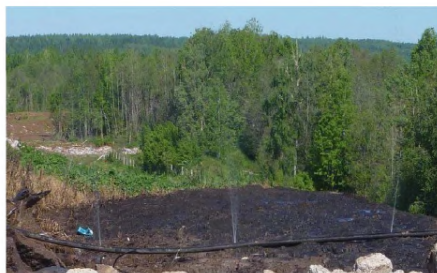
Рис. 2.18 — Распыление фильтрационных вод на поверхности ОРО ([55]) (ОРО ТКО в Пермском крае)
