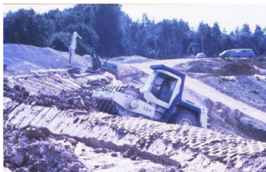
Рисунок 2.2 — Уплотнение глиняного экрана ([26])
