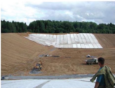
Рисунок 2.5 — Устройство ПФЭ из полимерной геомембраны на ОРО в Московской области ([26])
