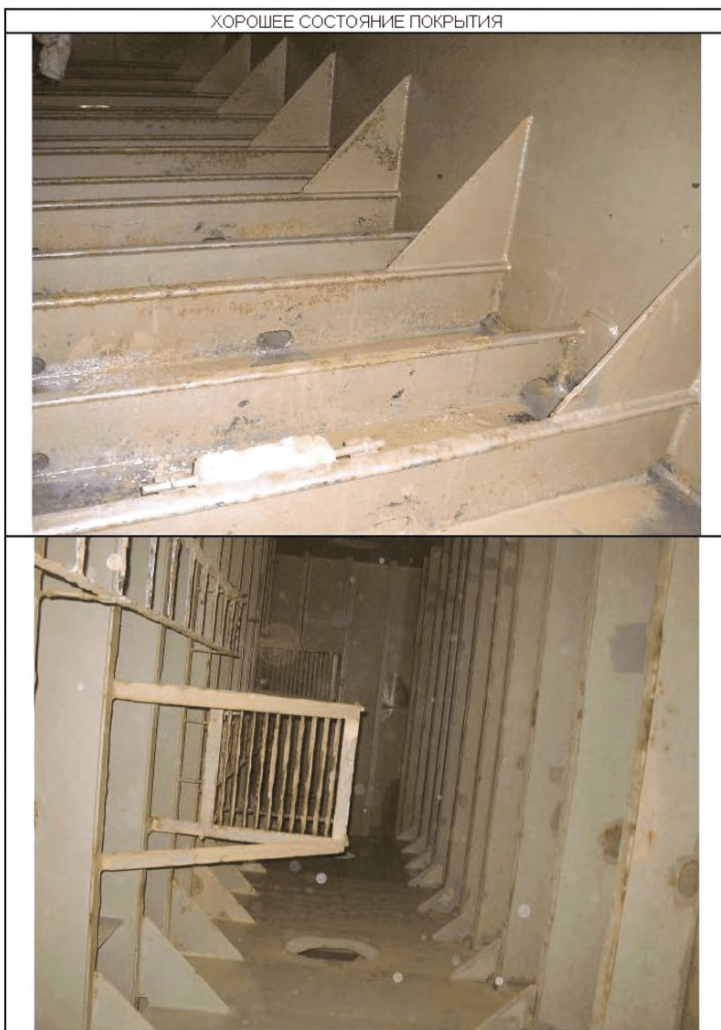
ХОРОШЕЕ СОСТОЯНИЕ ПОКРЫТИЯ
