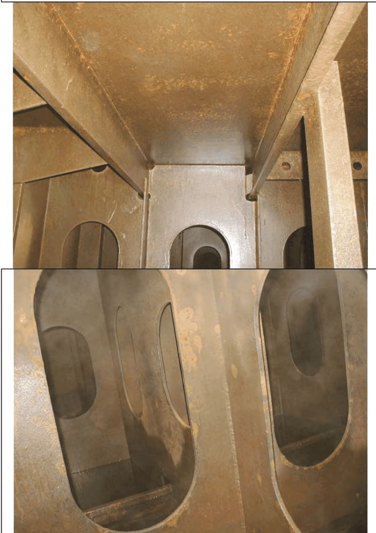
ХОРОШЕЕ СОСТОЯНИЕ ПОКРЫТИЯ
