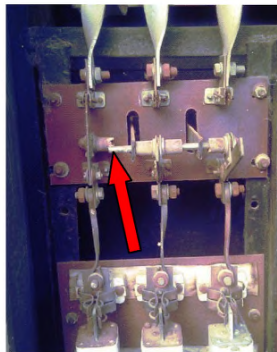
Рис. 2. Контакты рубильника в отключенном положении (произошел излом, одна фаза осталась не отключенной)
