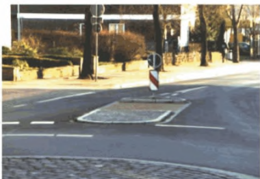
Рисунок 6.9 - Поднятый над уровнем проезжей части (а) и обозначенный краской (б) овальные островки [13]
