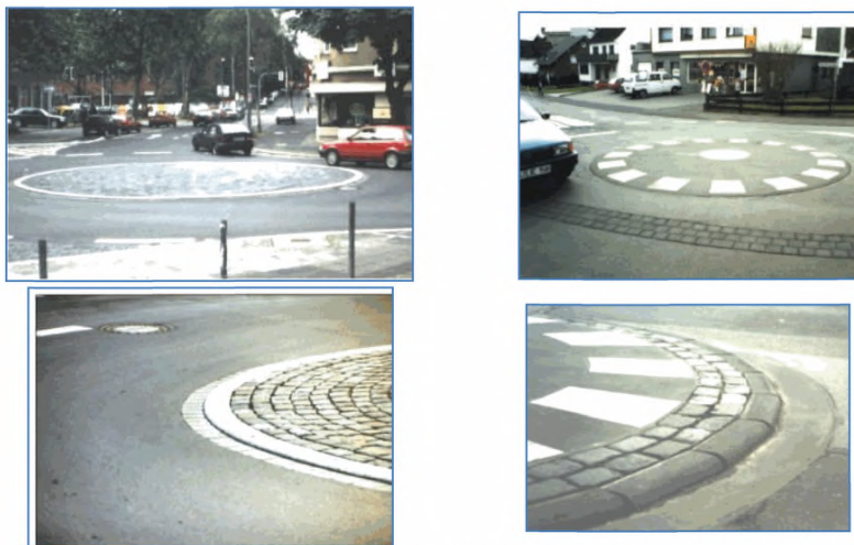
Рисунок 6.6 - Внешний вид центрального островка мини-кольцевых пересечений [13]
