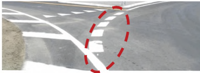
Рисунок 12.4 – Разметка граничной линии кольцевой проезжей части
