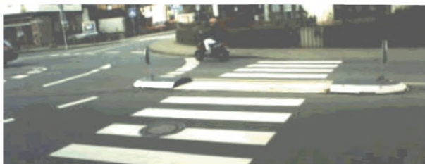
Рисунок 6.10 - Прорезанный приподнятый над уровнем проезжей части разделительный овальный островок [13]
