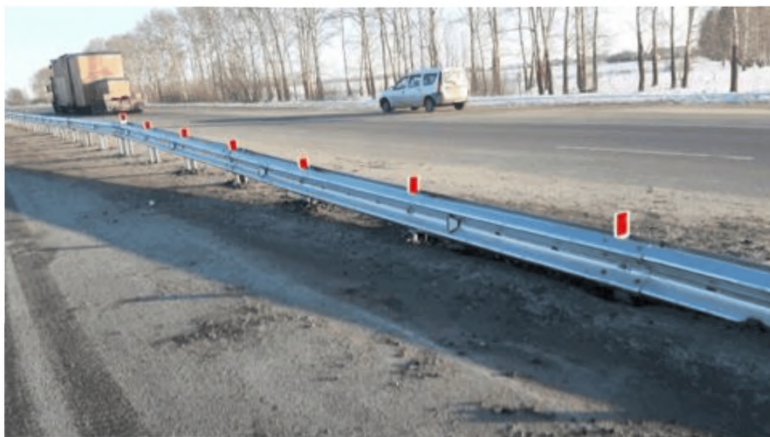
Рисунок 11 – Действующий экспериментальный объект участка федеральной автомобильной дороги М-4 «Дон»-Тамбов-Волгоград-Астрахань подъезд к г.Саратов км 504+500 – 729+594 в Саратовской области.
