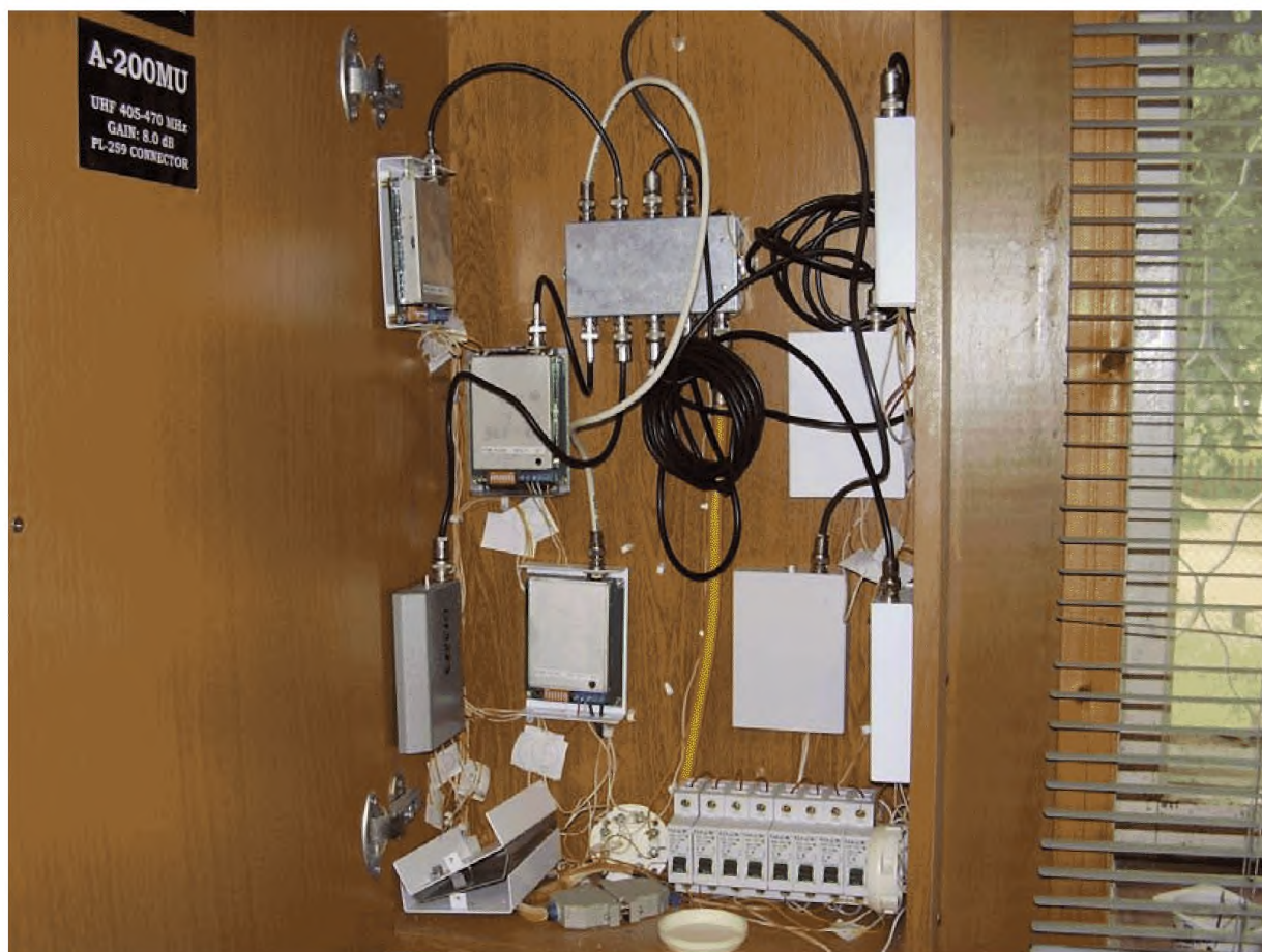
Рис. В5 Скручивать кабель в бухту недопустимо
