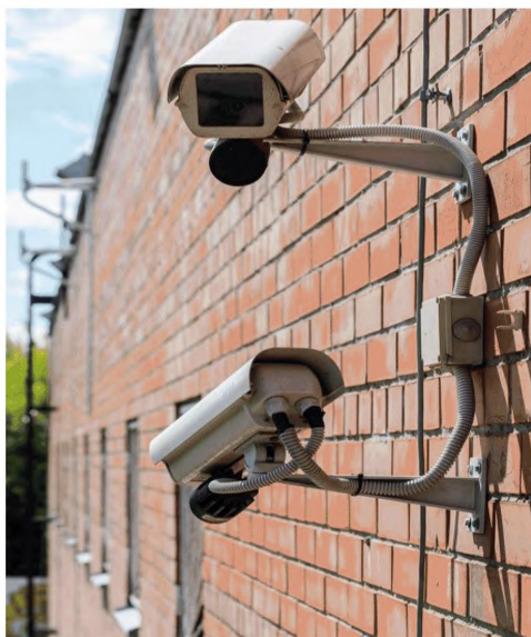
Рисунок 3. Установка ТК с ИК-прожектором.
