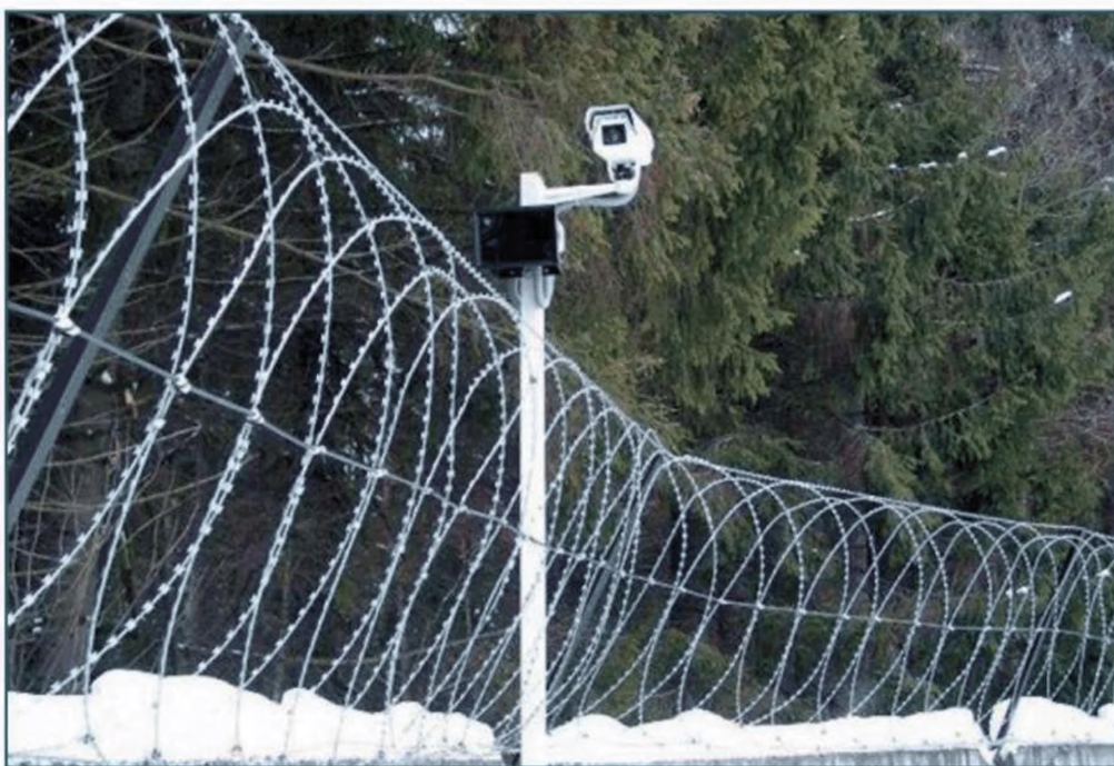
Рисунок 4. Установка ТК на столбе.
