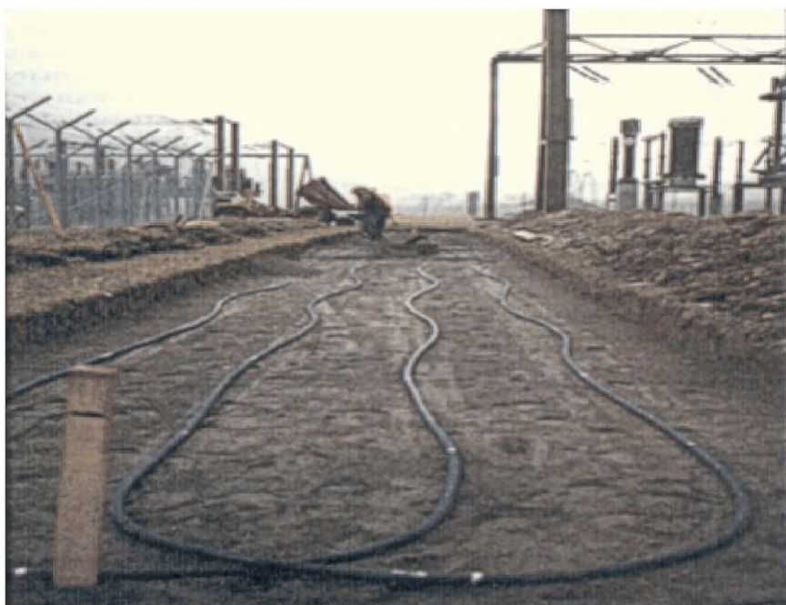
Рисунок 10. Установка чувствительного элемента (шлангов).
