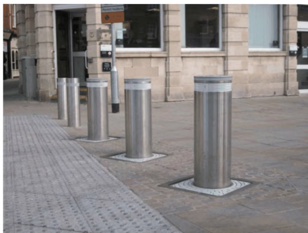
Рисунок 2. Телескопические столбы безопасности.
