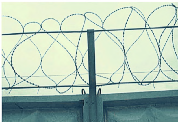
Рисунок 27. Установка ЧЭ на АКЛ.
