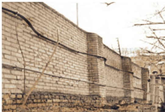
Рисунок 33. Установка ЧЭ на кирпичной стене.
