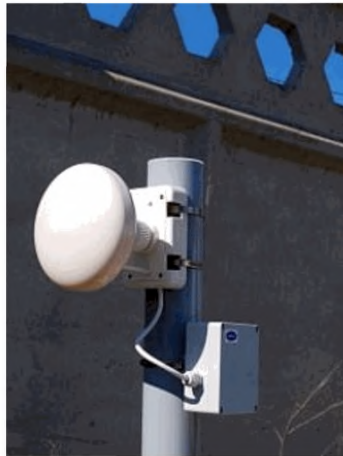
Рисунок 14. Пример установки РЛСО.
