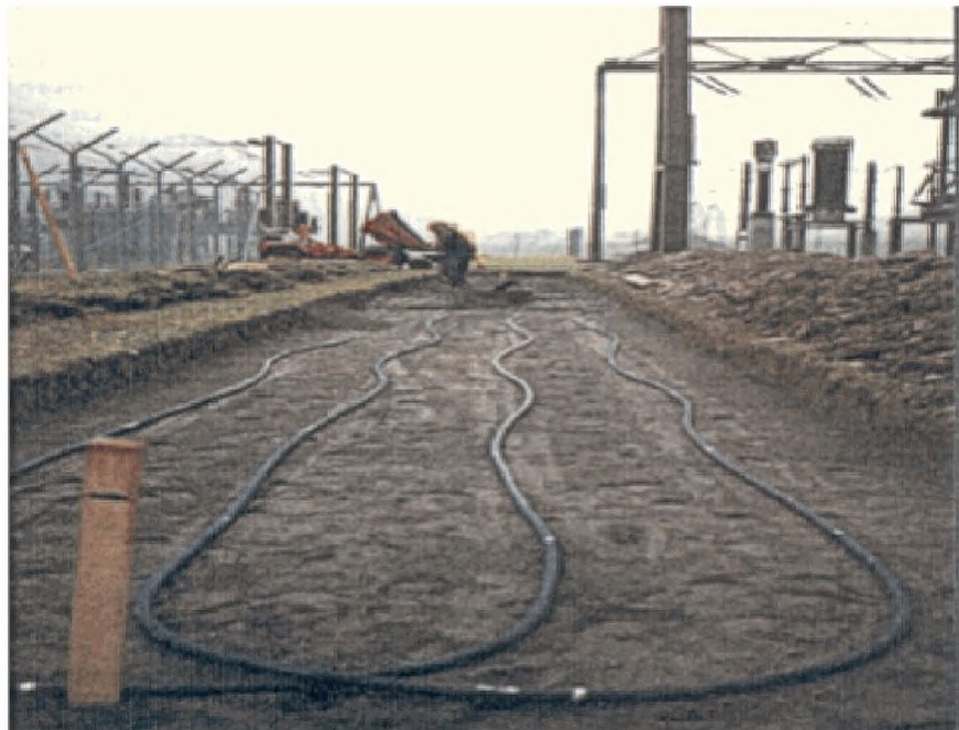
Рисунок 10. Установка чувствительного элемента (шлангов).
