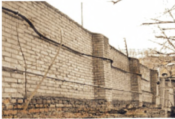
Рисунок 33. Установка ЧЭ на кирпичной стене.
