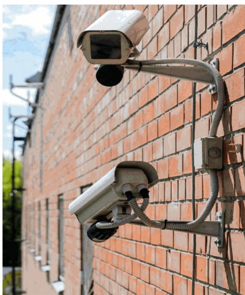
Рисунок 6. Установка ТК с ИК-прожектором на стене здания.
