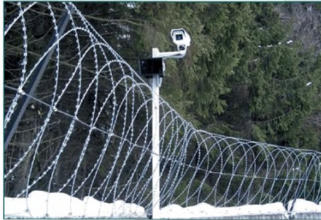
Рисунок 7. Установка ТК на столбе.
