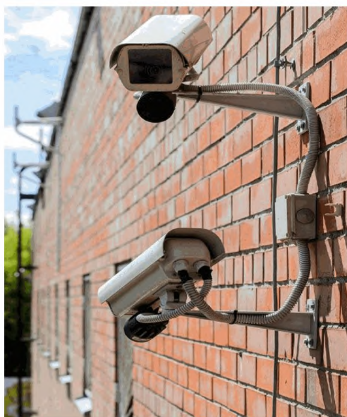
Рисунок 6. Установка ТК с ИК-прожектором на стене здания.
