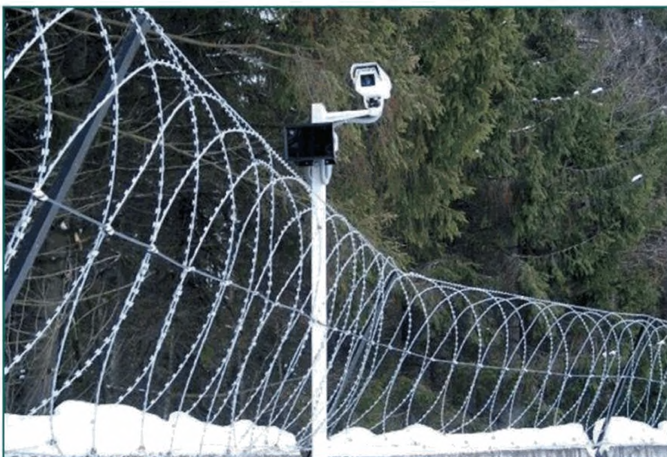
Рисунок 7. Установка ТК на столбе.
