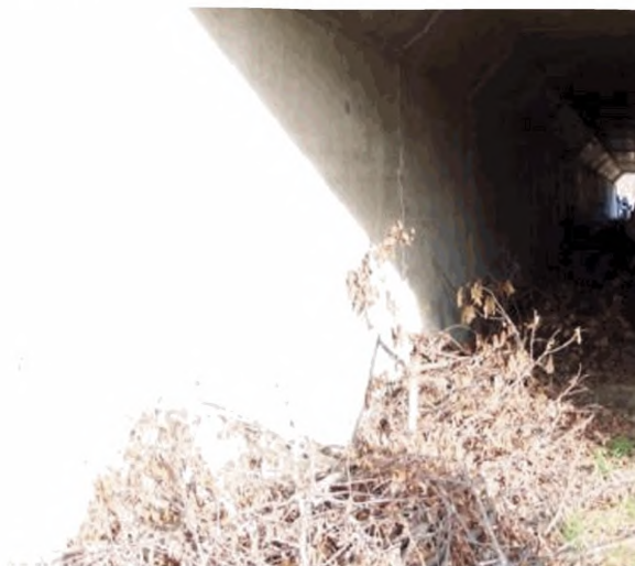
Рисунок 6 – Обустройство тоннелей вязанками хвороста
