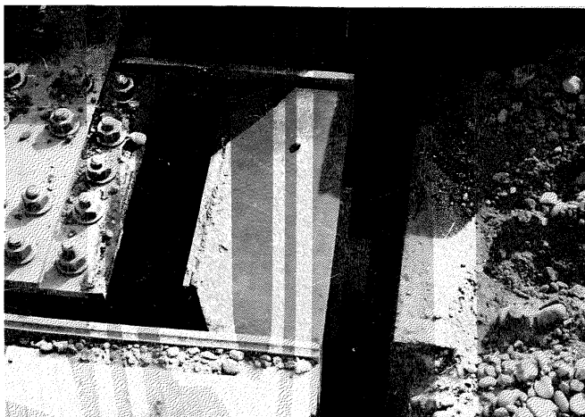
Рисунок А.4 – Буфер, установленный в рабочее положение
