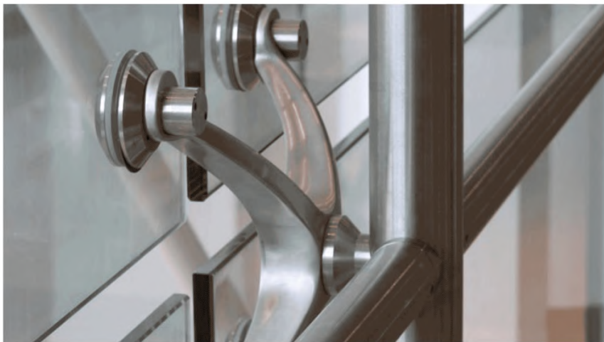
Рисунок 5.7 – Фрагмент спайдерного остекления
