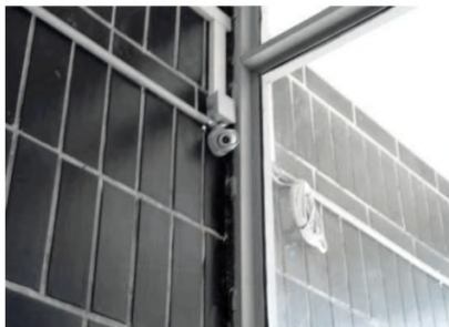
Видеокамера в подъезде
