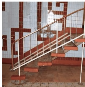
Рисунок 6.2.11 – Лестничный марш в вестибюле
