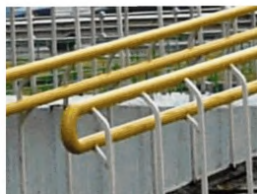
Рисунок 6.1.21 – Недопустимые конструкции креплений поручней на пандусе
