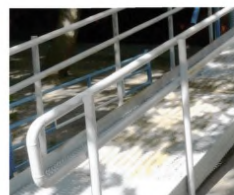
Рисунок 6.1.21 – Недопустимые конструкции креплений поручней на пандусе
