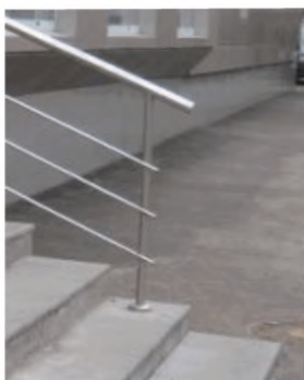
Рисунок 6.1.14 – Недопустимые варианты окончаний поручней
