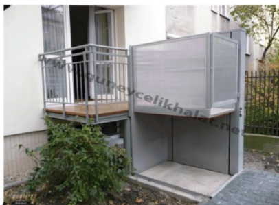
Рисунок 6.7.1 – Примеры подъемных платформ на входе в квартиру
