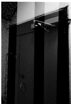
Рисунок 6.2.10 – Автоматические доводчики на входных дверях при узком тамбуре
