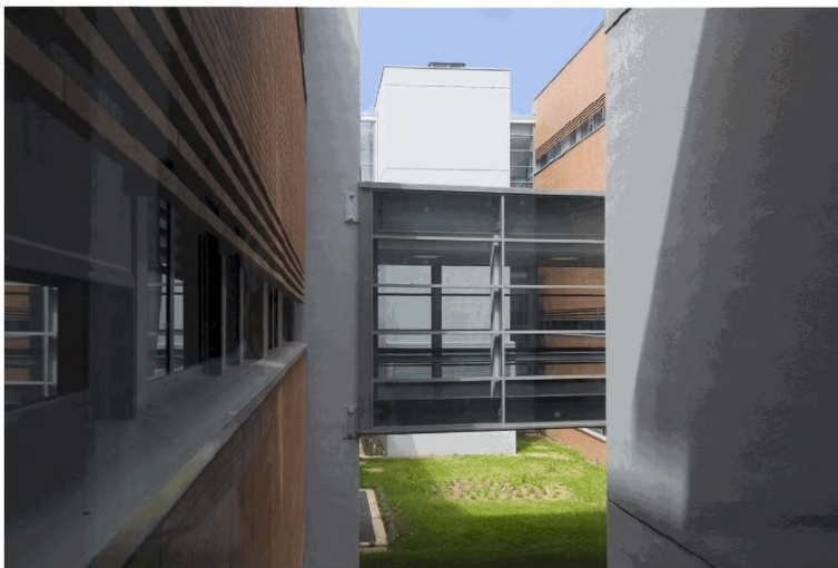
Рисунок 7 – Пример перехода между корпусами больницы
