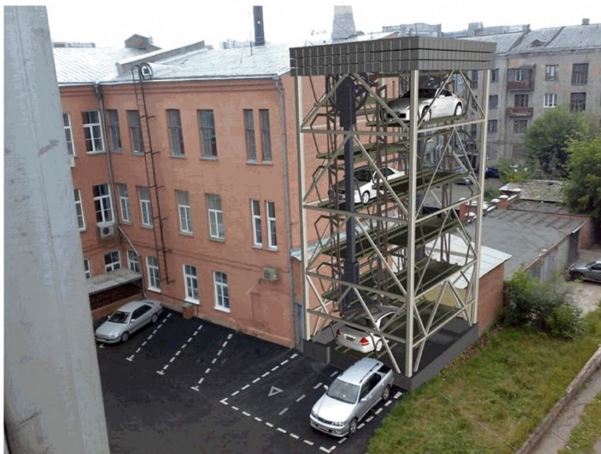
Рисунок 39 Пристроенная к глухой стене здания механизированная стоянка.
