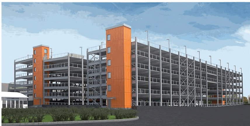
Рисунок 32 – Лестничные клетки в стоянках открытого типа
