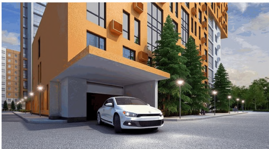
Рисунок 3 – Устройство над проемом стоянки глухого козырька из негорючих (НГ) материалов, перекрывающего ширину проема с каждой стороны более чем на 0,5 м
