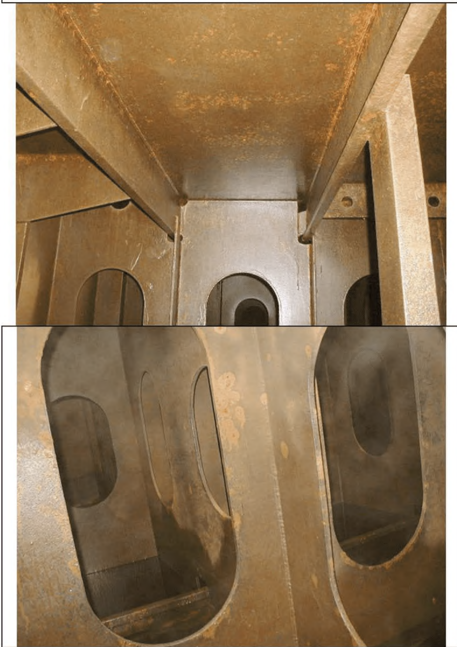
ХОРОШЕЕ СОСТОЯНИЕ ПОКРЫТИЯ
