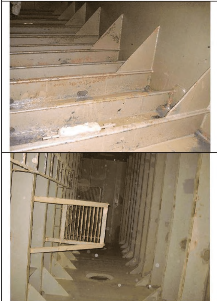
ХОРОШЕЕ СОСТОЯНИЕ ПОКРЫТИЯ
