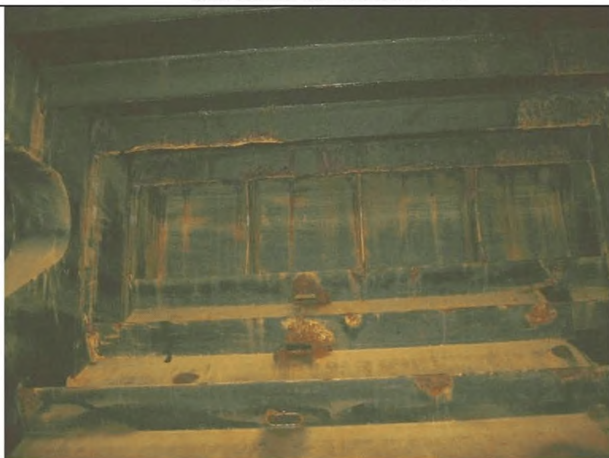
УДОВЛЕТВОРИТЕЛЬНОЕ СОСТОЯНИЕ ПОКРЫТИЯ
