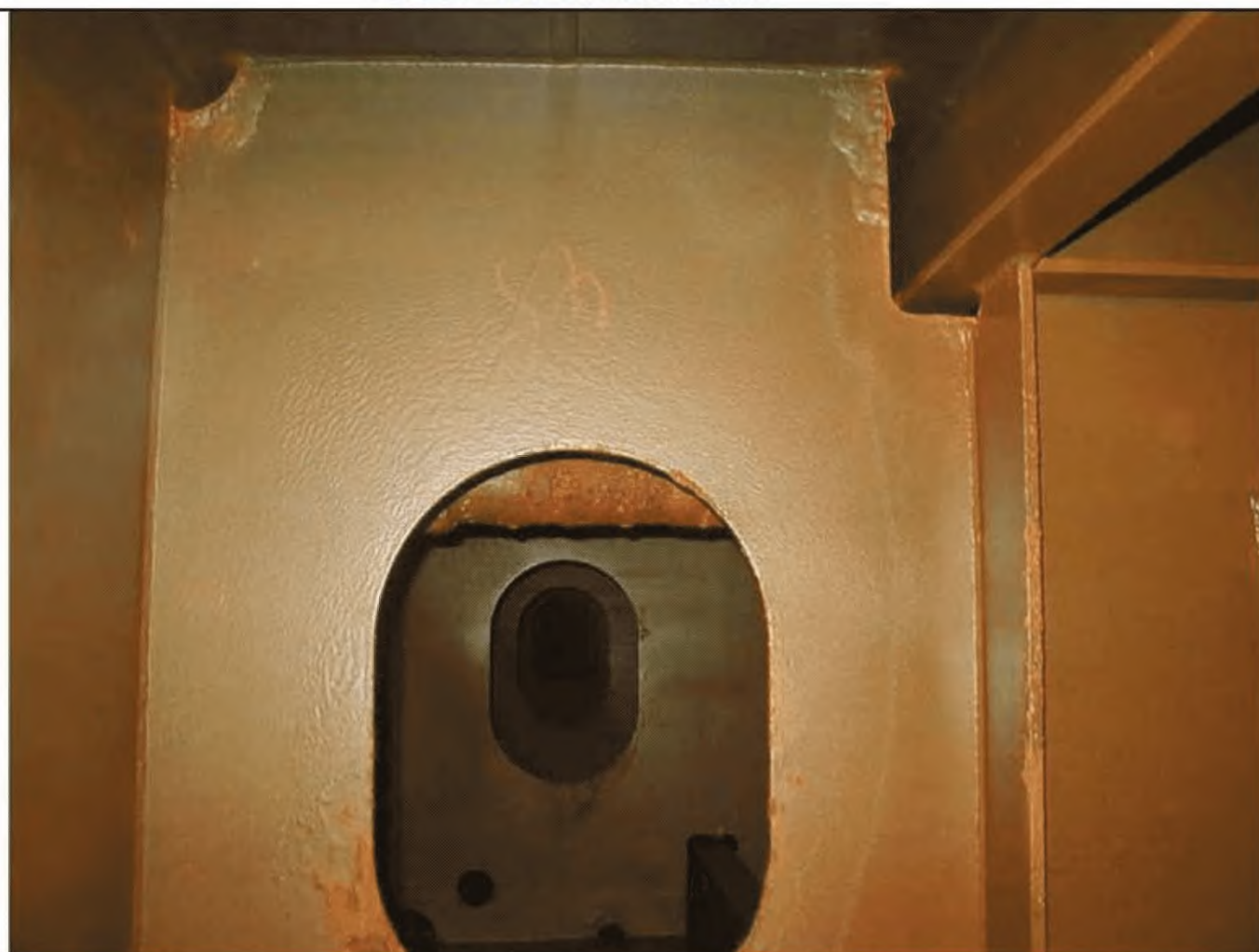
ХОРОШЕЕ СОСТОЯНИЕ ПОКРЫТИЯ
