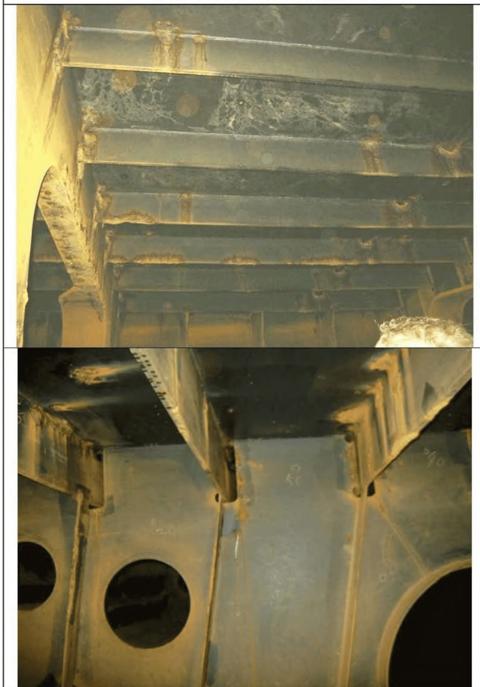
УДОВЛЕТВОРИТЕЛЬНОЕ СОСТОЯНИЕ ПОКРЫТИЯ
