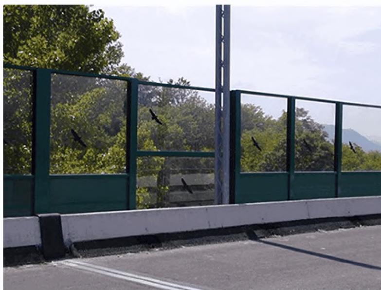
Рисунок А.5 — Нанесение силуэтов хищных птиц на прозрачные экраны
