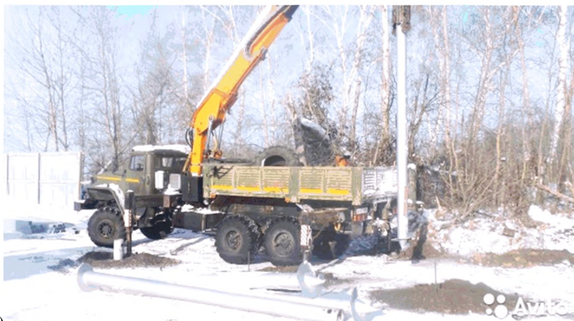
Рисунок Е.2 – Пример монтажа свай СВЛ: а) с использованием электрического закручивающего устройства; б) с использованием гидравлического закручивающего устройства: универсальной бурильной машины УБМ-85 на базе грузового автомобиля УРАЛ
