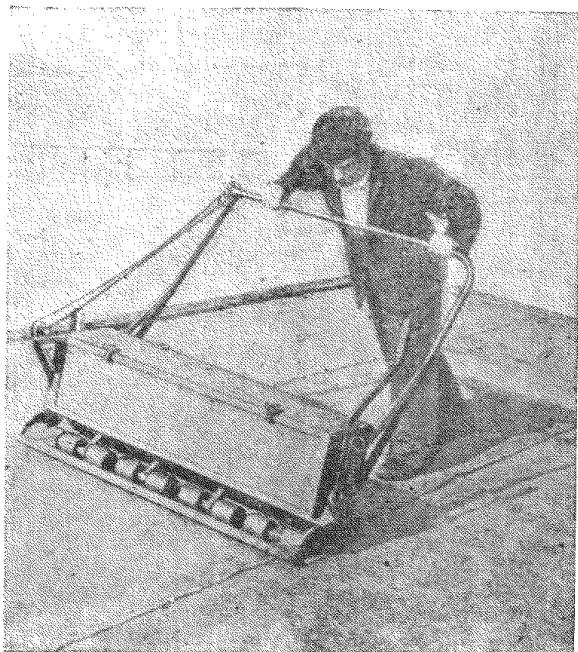
Рис. 25. Прикатка рулонного материала дифференциальным катком
