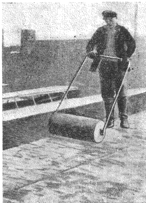
Рис. 26. Прикатка рулонного материала цилиндрическим катком
